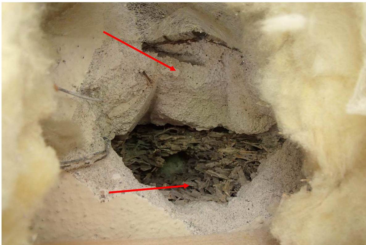
Kuva 12. Alkuperäisen ulkoseinän ja ulokkeen rajapinnassa havaittiin lastuvillaeristys (Toja) sekä kevytbetonieristys (Siporex) ulkoseinillä.
