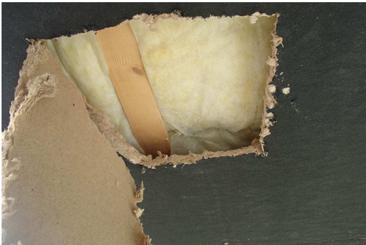
Kuva 8. Rakenneavaus ulokkeen alapinnasta: tuulensuojalevy ja koolaus/eristys.
