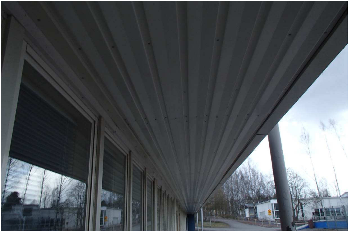
Kuva 7. Yleiskuva rakennuksen eteläsivun ulokkeen alapinnan pellityksestä.
