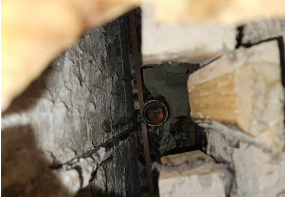
Kuva 7. Putkiläpivienti näyttämöllä. Näyttämörakenteiden alla näkyi betonilaatta.
