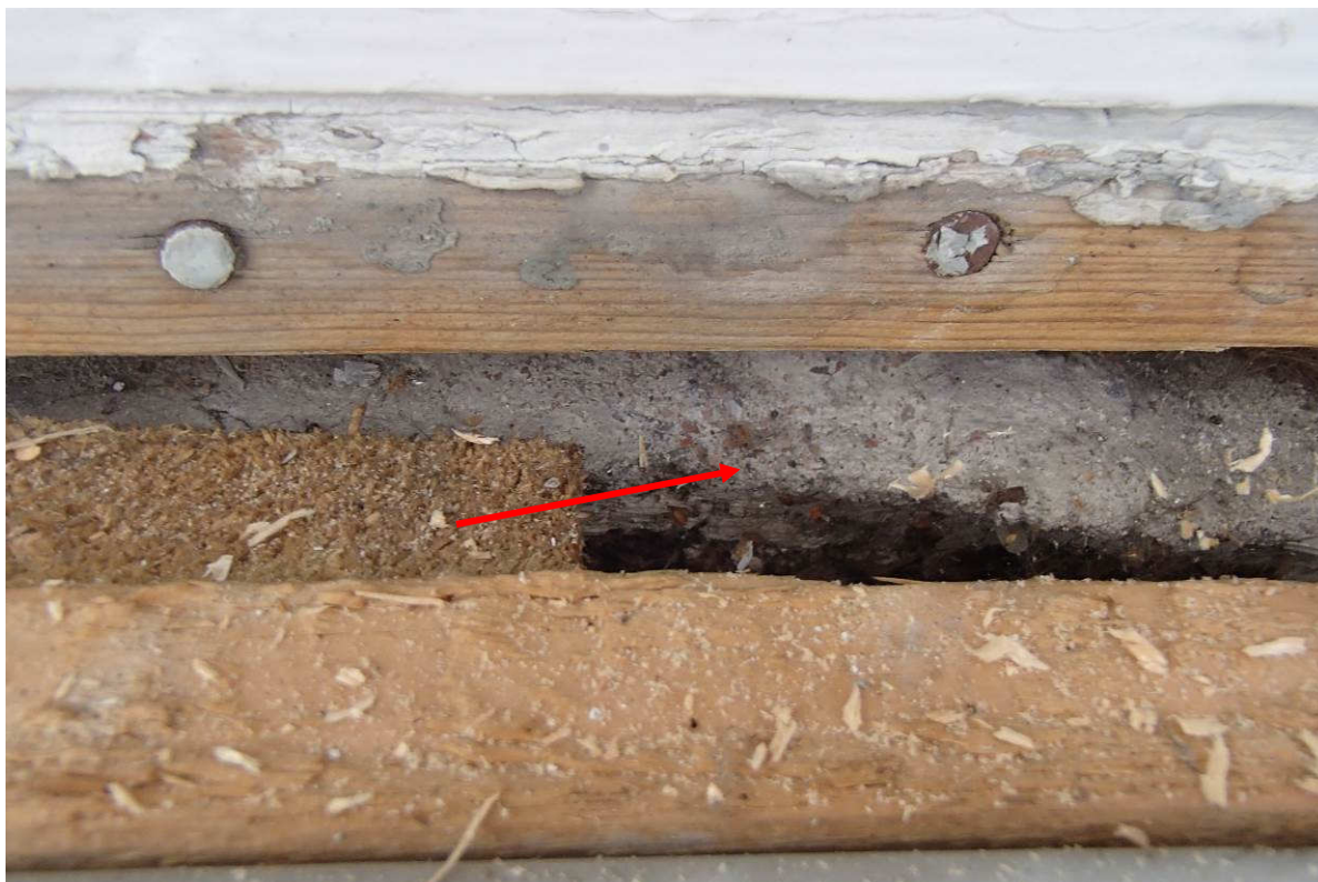
Kuva 18. Osa yläikkunoista oli asennettu paikallaan valetun betonipedin päälle.
