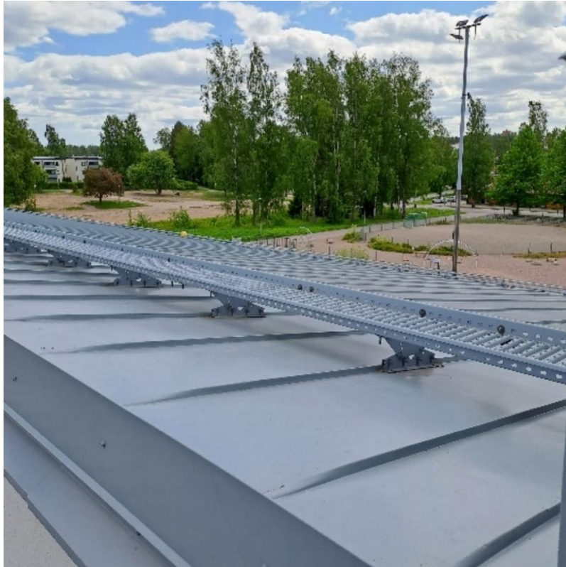
Kuva 5.13 Vanhan osan vesikatto on silmämääräisesti hyväkuntoinen (etelärakennus).
