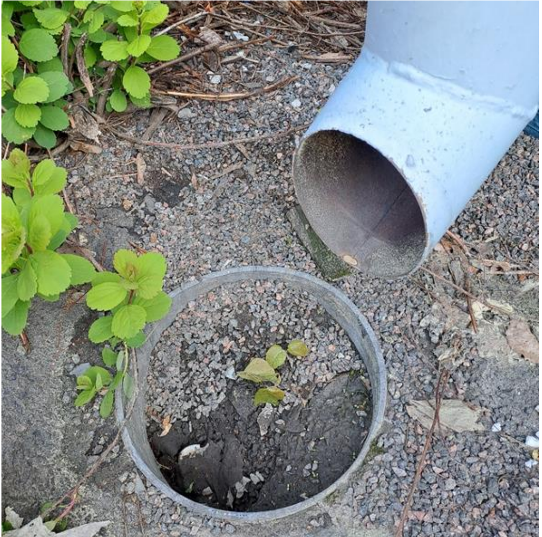
Kuva 5.15 Maantasossa olevat kaivot tukkeutuvat erittäin herkästi.
