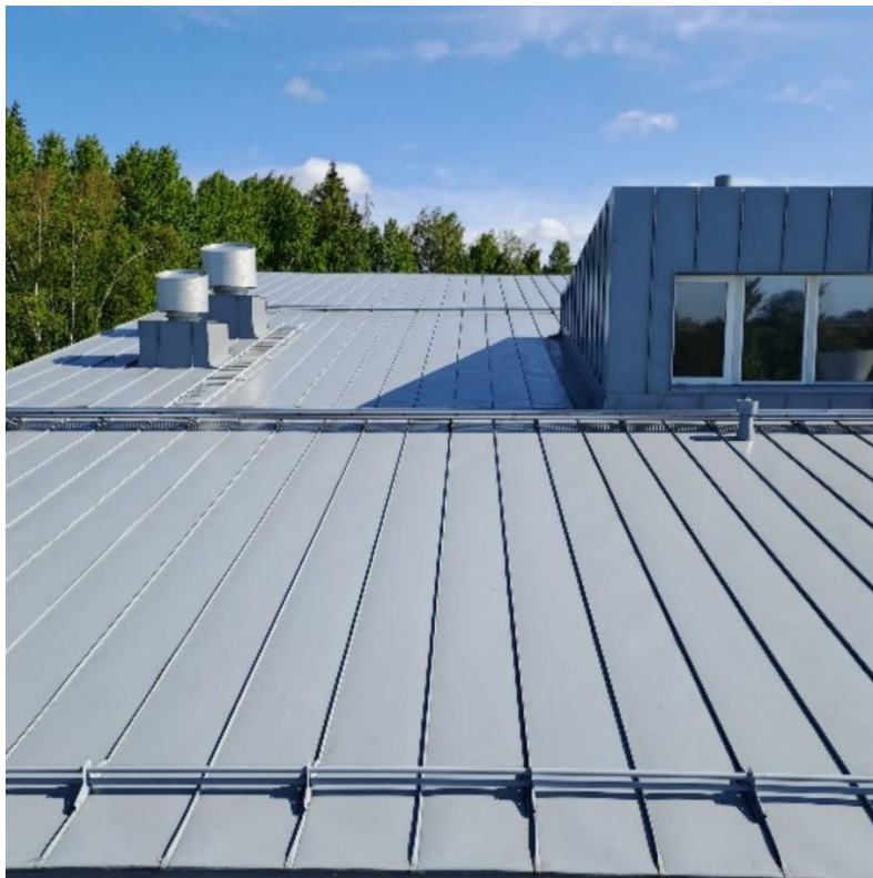
Kuva 5.12 Vanhan osan vesikatto on silmämääräisesti hyväkuntoinen (pohjoisrakennus).
