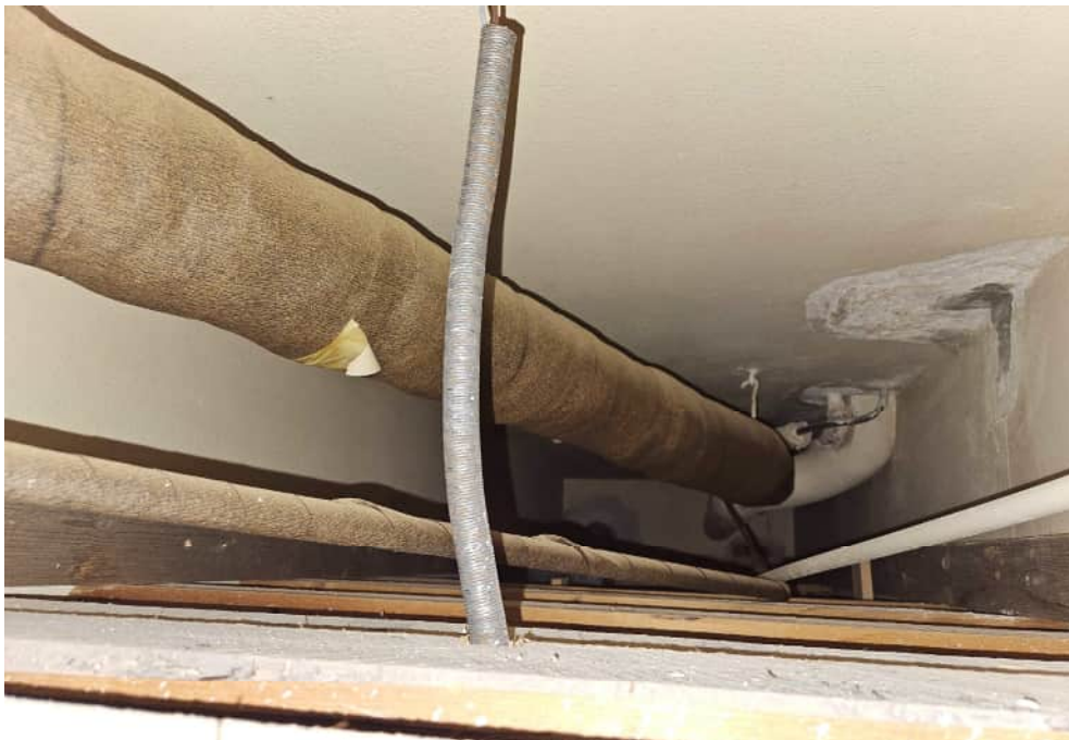
Kuva 4. Kipsilevyistä tehty alakattorakenne oppilaskunnan huoneessa 1. kerroksessa.
