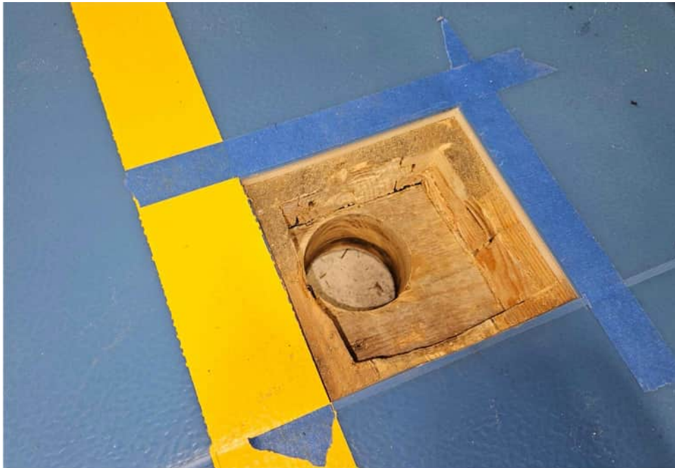
Kuva 5. Rakenneavaus liikuntasalissa. Puurakenteiden läpi tehtiin suurempi avaus, minkä jälkeen betonilaatasta porattiin pienellä terällä läpi laatan paksuuden määrittämiseksi.
