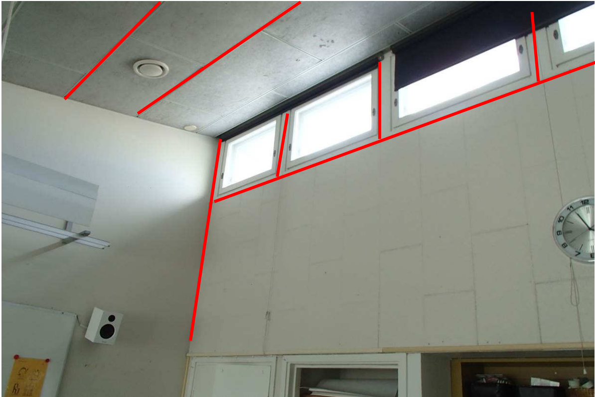
Kuva 60. Rakenneliitosten ilmavuotokohdat.
