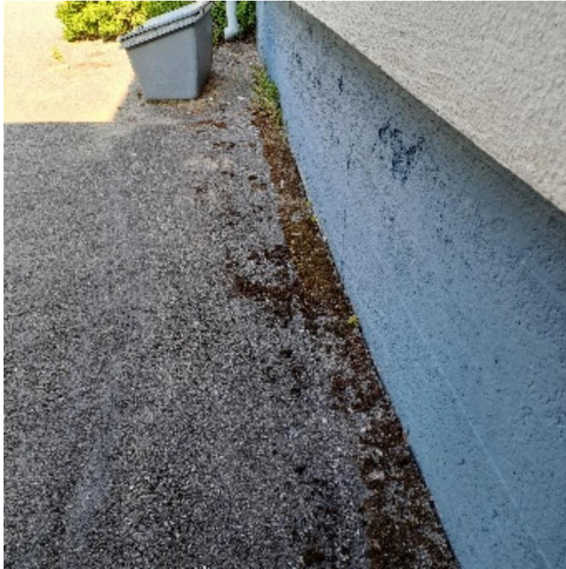
Kuva 5.7 Sammalkasvusto indikoi kosteuden kertymistä sokkelin juurelle.
