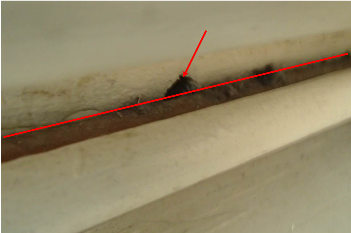
Kuva 62. Rakenneliitosten ilmavuotokohdat.
