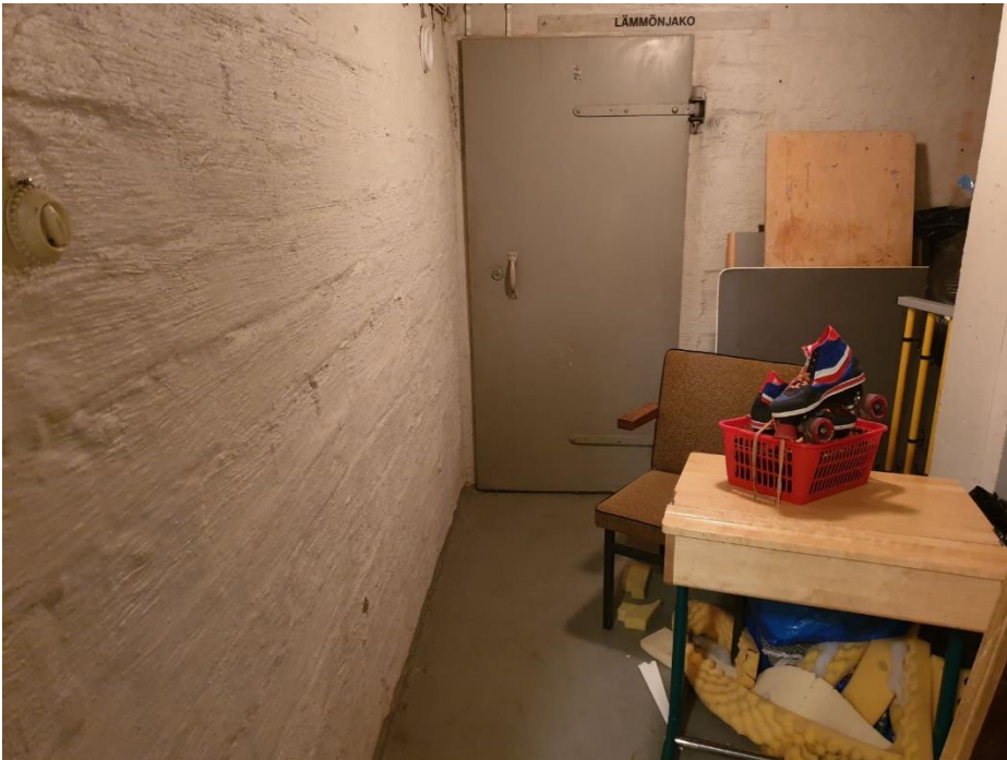
Kuva 5. Vanha osa, varasto, seinien ja lattia maalipinnat mahdollisesti sisältävät haitta-aineita. Näytteet Asb/RM15 lattia, Asb/RM16 seinät (Asb=asbesti, RM=raskasmetallit).
