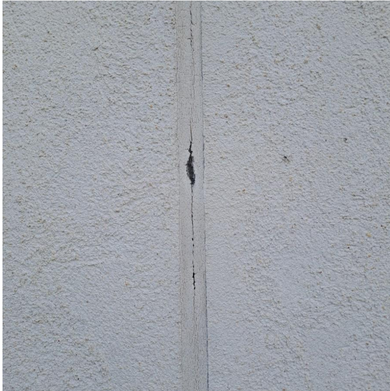
Kuva 5.20 Elastiset saumat ovat ohuita ja halkeilevia.
