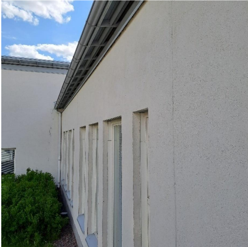
Kuva 5.16 Laajennuksen julkisivurappaus on pääosin hyvässä kunnossa
