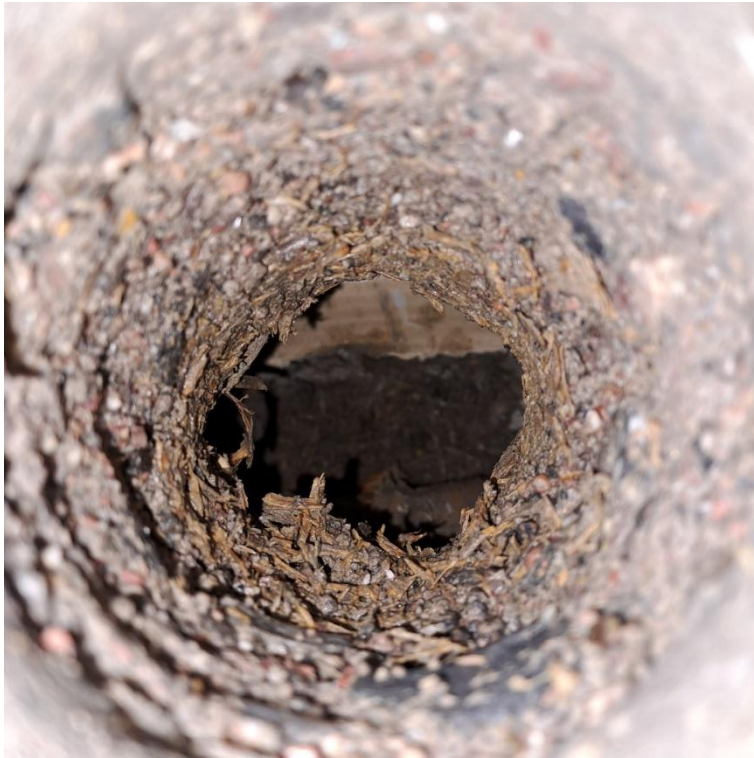
Kuva 4.2 Toja-levyeristettä alapohjan alapinnassa vanhassa rakennusosassa, opetustila 1.42
